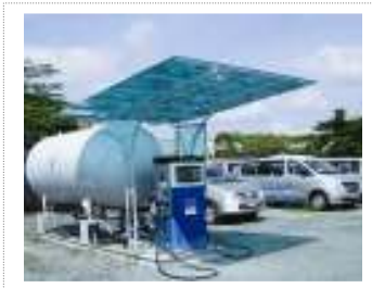
Hình 1 : Trạm Autogas tại Tp.HCM
