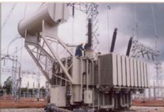
Lắp đặt điện thế 250MVA - 220/110 KV trạm điện Long Thành Đồng Nai
