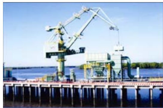
Cung cấp, chế tạo và lắp đặt cầu béc Clinker 600 tấn/giờ Trạm nghiền Xi măng Cẩm Phả
