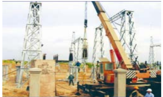
Lắp đặt trạm điện 110kV Nhà máy thủy điện Srock Phu Miêng - Bình Phước
