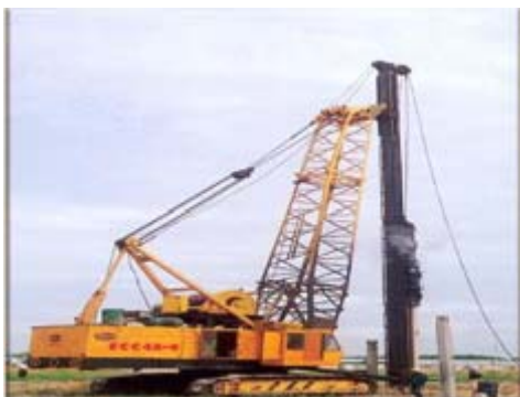
Đóng cọc tại công trình kính nổi Bình Dương
