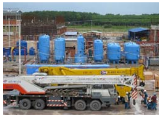
Lắp đặt nhà máy giấy Bình Dương Vina KRAF
