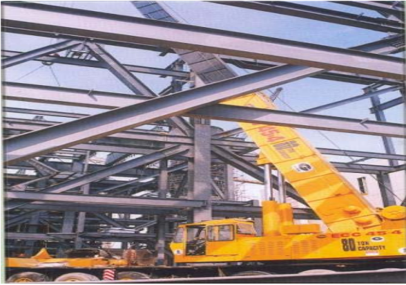
Chế tạo, lắp dựng kết cấu khung lò hơi - Nhà máy nhiệt điện Phú Mỹ Đồng Nai
