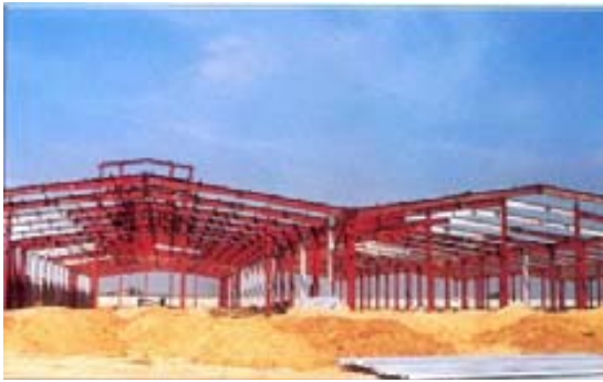
Chế tạo và lắp đặt kết cấu nhà máy gạch Đồng Nai
