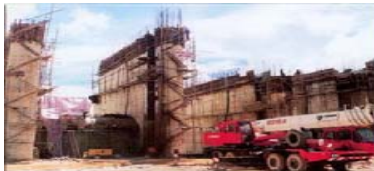
Thi công xây dựng đập tràn xả lũ - Dự án thủy điện Hàm Thuận - Đa Mi
