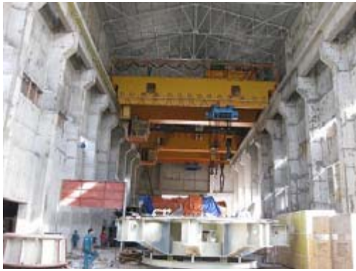
Lắp đặt máy phát điện sông Ba Hạ
