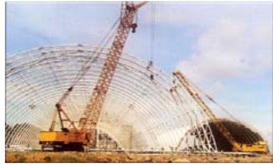
Chế tạo và lắp dựng nhà vòm khẩu độ 58m Nhà máy xi măng Sao Mai - Kiên Giang
