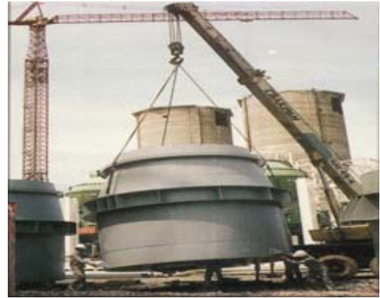
Lắp đặt Silo thu bụi nhà máy xi măng Sao Mai - Kiên Giang. Nhà máy xi măng Sao Mai
