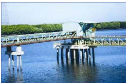
Cung cấp, chế tạo và lắp đặt khung băng tải ngoài cảng. Chế tạo và lắp đặt thiết bị xuất bao trạm nghiền Xi măng Cẩm Phả
