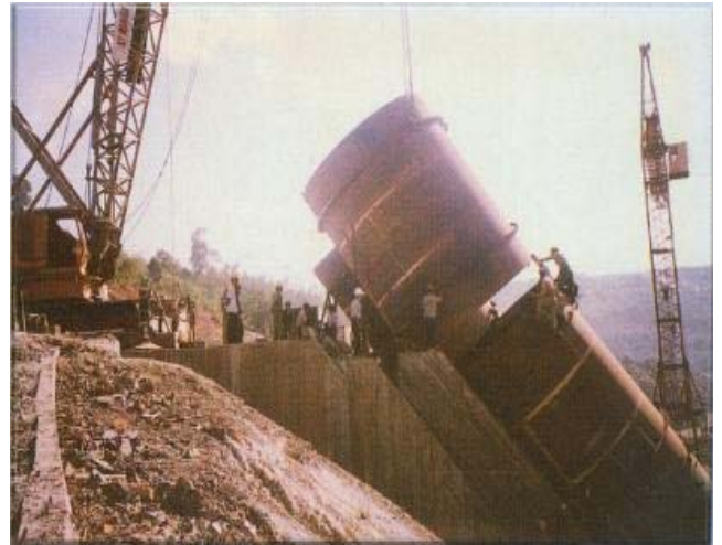
Chế tạo và lắp đặt đường ống áp lực Nhà máy thủy điện Thác Mơ ở độ nghiêng 52 độ
