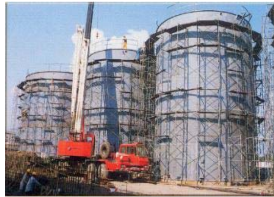
Chế tạo và lắp đặt bồn dầu 3.000 m 3
