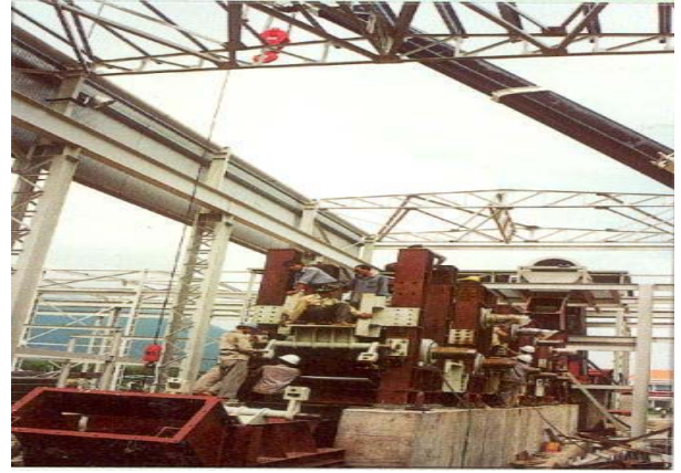
Lắp đặt thiết bị chèn ép nhà máy đường Tây Ninh
