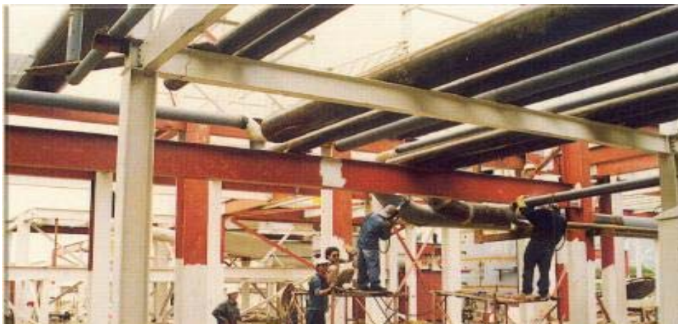
Hàn ống dẫn dầu cho nhà máy nhiệt điện Phú Mỹ
