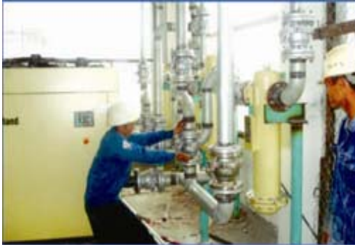
Cung cấp và lắp đặt hệ thống ống và thiết bị Nhà máy sơn ICI- Bình Dương
