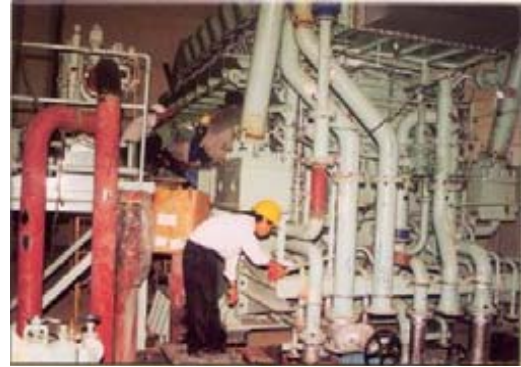
Trạm phát điện DIEZEL 24.000 MVA – Sao Mai
