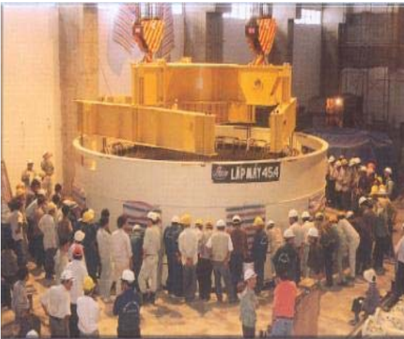
Tổ hợp lắp đặt Stator nhà máy Thủy điện Hàm Thuận
