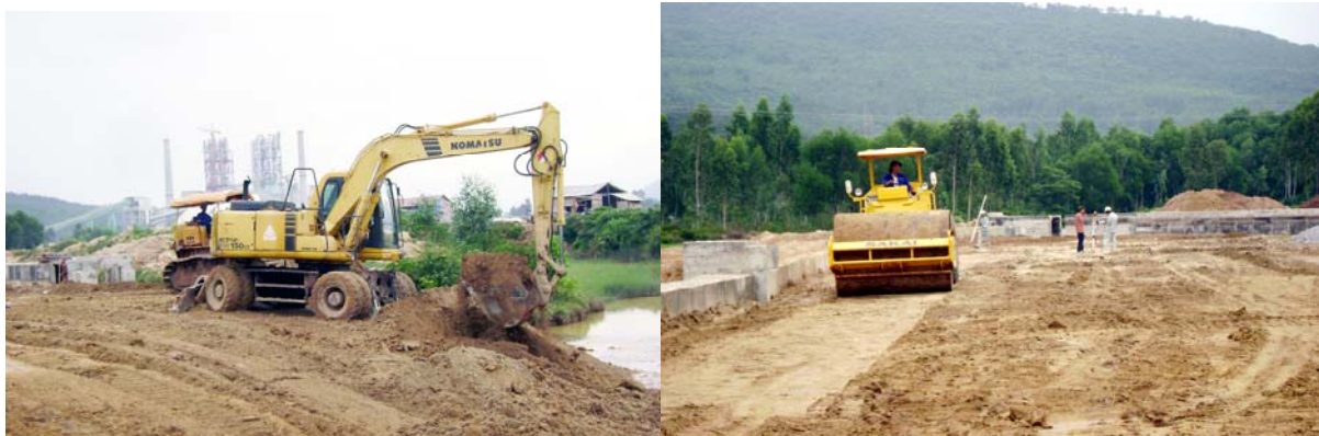
Hình ảnh thi công Dự án năng lượng nông thôn II Hưng Yên
