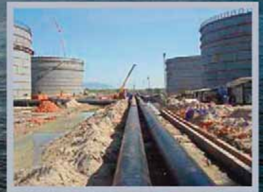
XÂY DỰNG KHO XĂNG DẦU CÙ LAO TÀO
