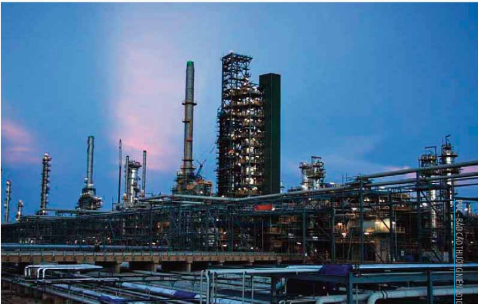
DỰ ÁN NHÀ MÁY ĐIỆN CÀ MAU 1
