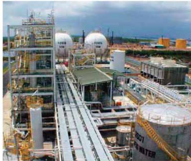
DỰ ÁN CHẾ TẠO BỐN BỂ CÔNG TRÌNH NHÀ MÁY ĐẠM PHỤ MỸ
