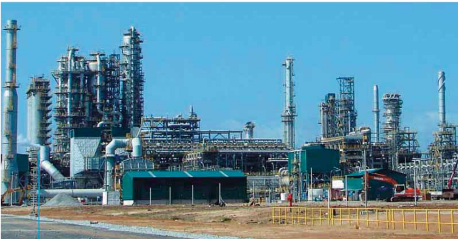
NHÀ MÁY LỌC DẦU DUNG QUẤT
