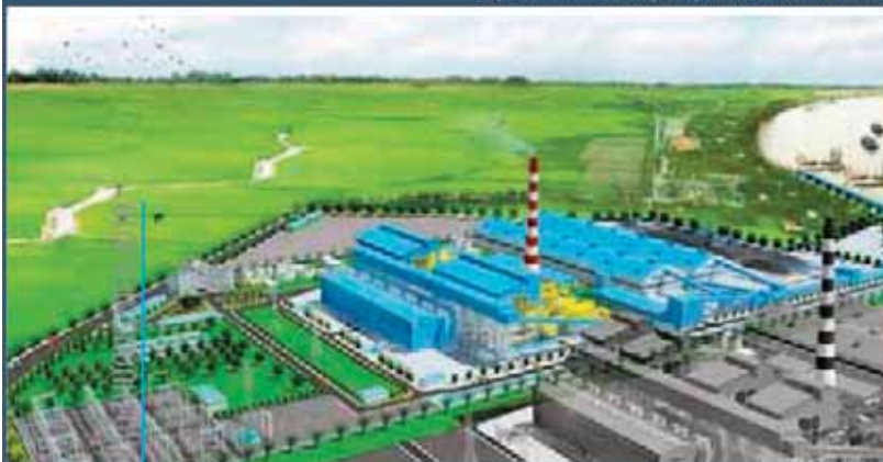
DỰ ÁN NHÀ MÁY NHIỆT ĐIỆN THÁI BÌNH
