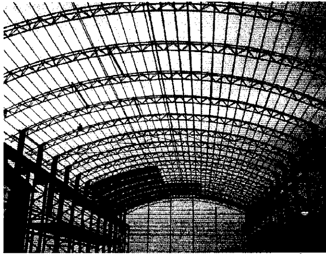
Công trình nhà thép được sản xuất từ chính sản phẩm ống thép của công ty mang lại chuỗi giá trị cao từ 2011
