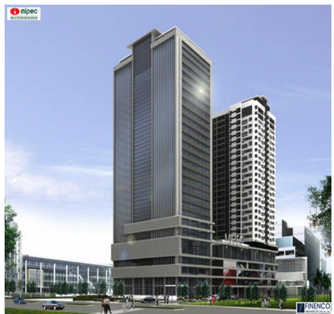
Dự án Mipec Tower
