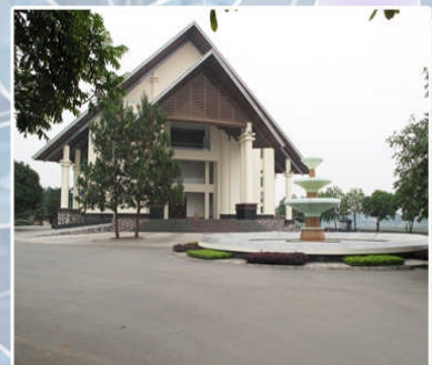
Dự án Khách sạn Sông Hồng TP. Vinh Yên
