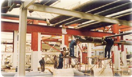
Hàn ống dẫn dầu cho nhà máy Nhiệt điện Phú Mỹ
