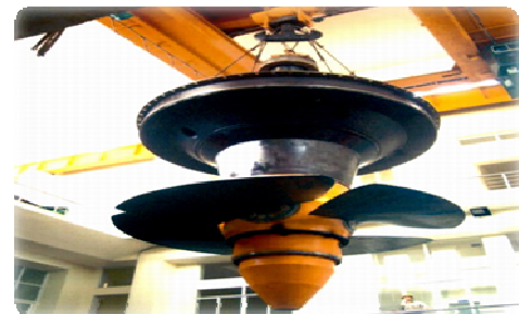
Lắp đặt bánh xe công tác cho Nhà máy thủy điện Srock Phu Miêng
