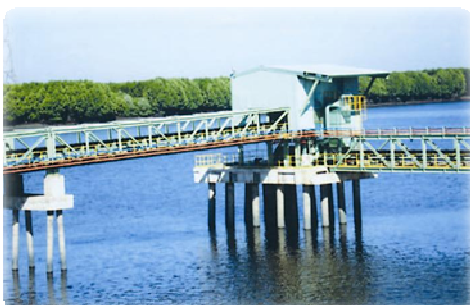
Cung cấp, chế tạo và lắp đặt khung băng tải ngoài cảng. Chế tạo và lắp đặt thiết bị xuất bao trạm nghiền Xi măng Cẩm Phả
