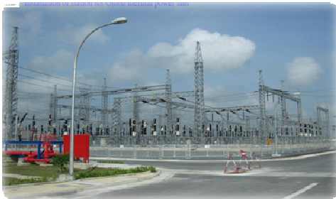
Lắp đặt hệ thống trạm nhiệt điện Ô Môn
