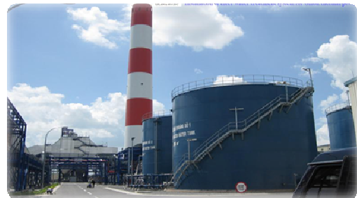
Lắp đặt hệ thống xử lý bồn nước lọc nhà máy nhiệt điện Ô Môn
