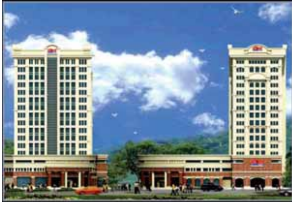
NHÀ LÀM VIỆC BỘ MÁY ĐIỀU HÀNH XHLD VIETSOVPETRO
