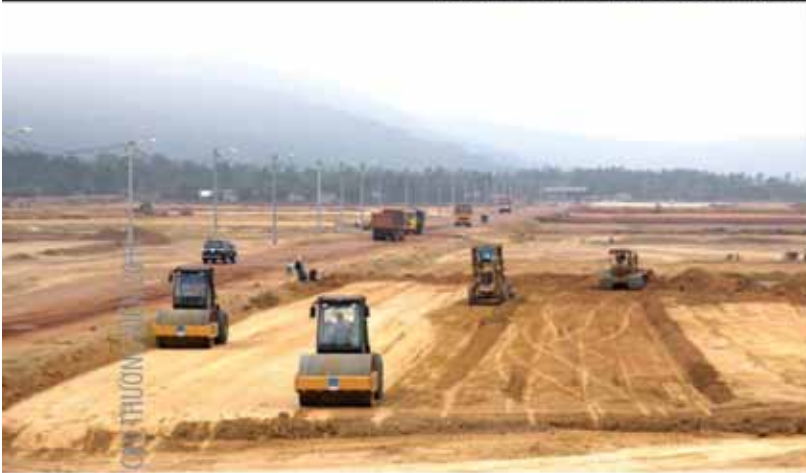
SAN LẤP MẶT BẰNG DỰ ÁN KHU LIÊN HỢP LỘC HÓA DẦU NGHĨ SƠN
