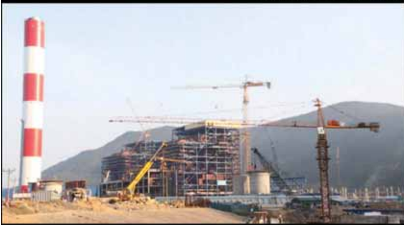
DỰ ÁN NHÀ MÁY NHIỆT ĐIỆN VŨNG AN - HÀ TĨNH
