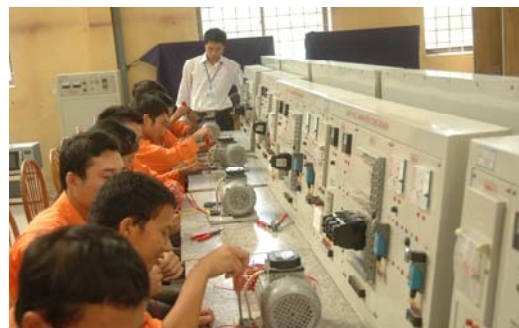
Thực hành nghề điện tại Trường CĐN SIMCO
