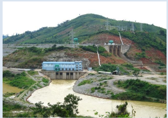
Nhà máy Thủy điện Buôn Tua Srah
