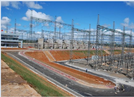
TBA 500kV Đắk Nông
