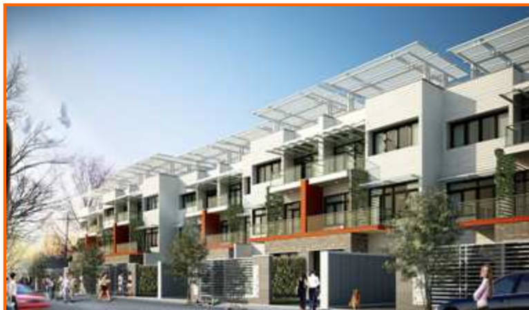
Dự án Khu nhà ở chung cư, liền kề và dịch vụ tổng hợp Dầu khí Trường Thi
