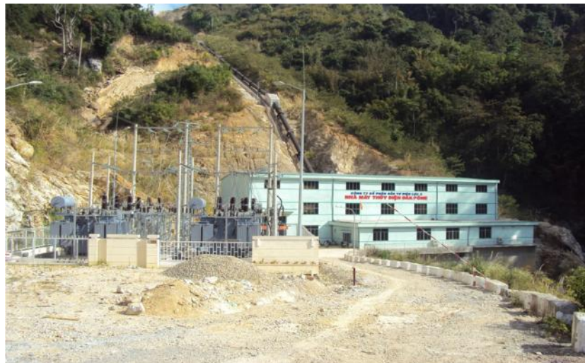
Toàn c nh Nhà máy thủy i n k Pône
