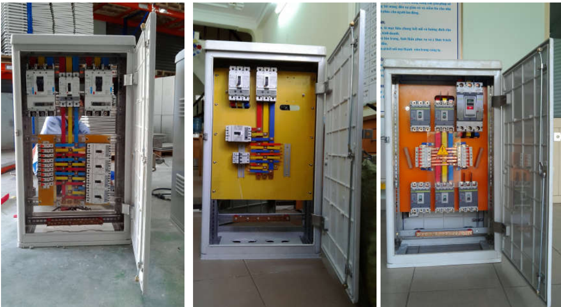
Tủ điện 3 pha lắp đặt điện kế và CB
