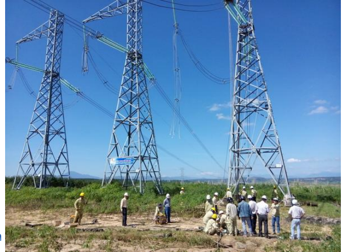
Đường dây 220kV An Khê – Quy Nhơn
