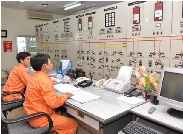
Trạm biến áp 220kV Ninh Bình
