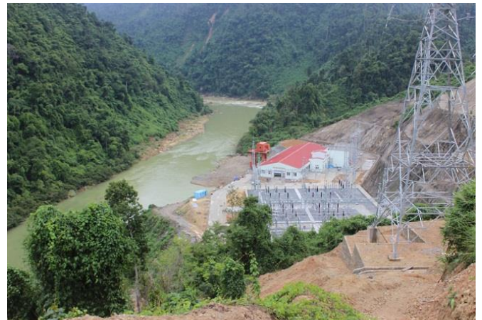
Nhà máy Thủy điện Sông Bung 4
