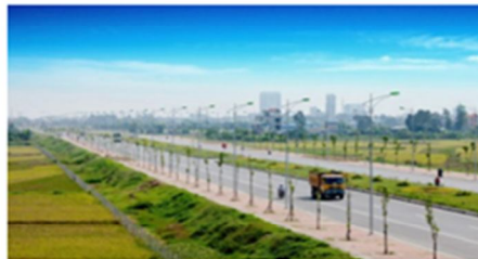
DỰ ÁN ĐẦU TƯ XÂY DỰNG TUYẾN ĐƯỜNG BỘ MỚI ĐOẠN PHỦ LÝ - MỸ LỘC
