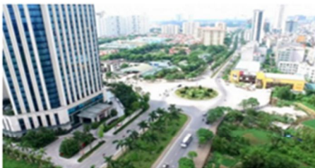
DỰ ÁN XÂY DỰNG TUYẾN ĐƯỜNG TỪ ĐƯỜNG LÊ ĐỨC THỌ ĐẾN ĐƯỜNG 70 (HỢP ĐỒNG BT)
