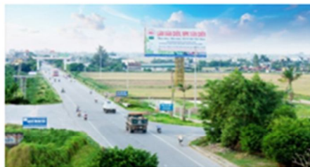
DỰ ÁN XÂY DỰNG CÔNG TRÌNH NÂNG CẤP ĐƯỜNG TỈNH 39B THÁI BÌNH (HỢP ĐỒNG BT)
