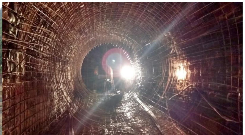
Thi công hầm dẫn nước NMTĐ Đa Krông 1
