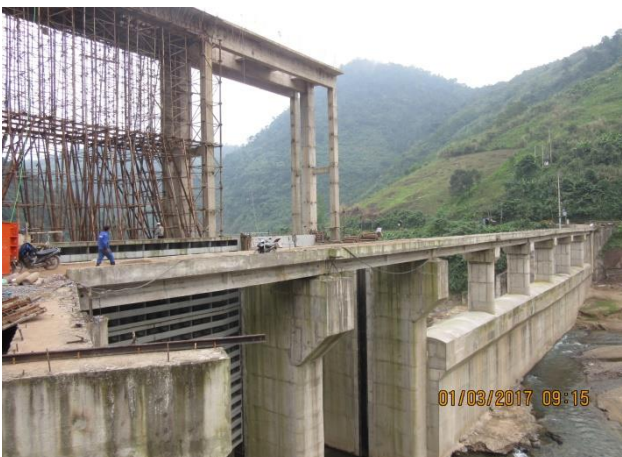
Đập dâng, đập tràn NMTĐ Đa Krông 1
