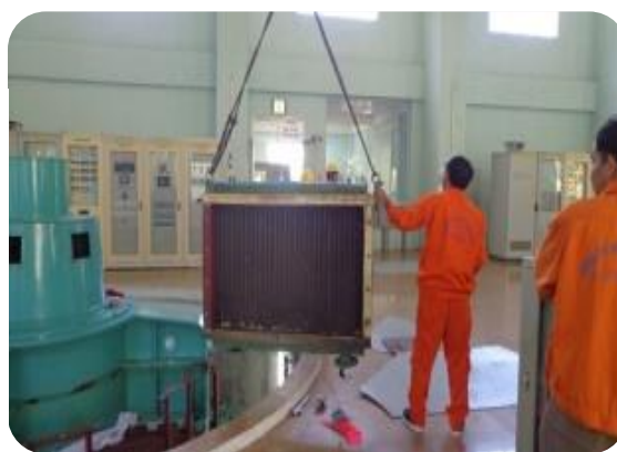
Thực hiện trung tu tại NMTĐ Đắk Pône
