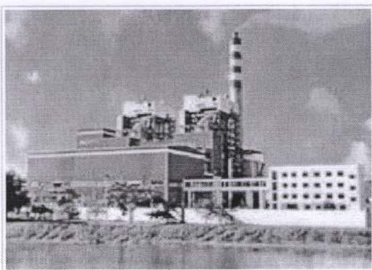
Công trình nhiệt điện Long Phú
