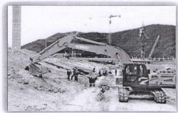
Công trình nhiệt điện Vũng Áng
