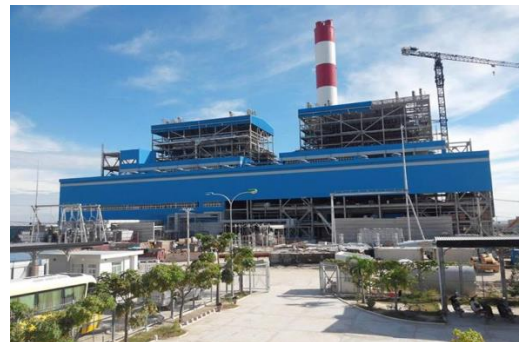
Khảo sát Nhà máy Nhiệt điện Vĩnh Tân 2
