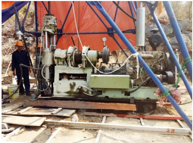
Khoan khảo sát địa chất công trình thủy điện tích năng Bác Ái
