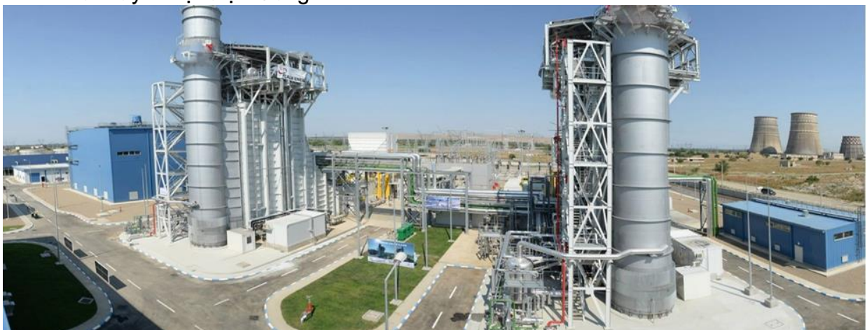
Đề án tăng công suất, hiệu suất cho Nhà máy điện Phú Mỹ 1
