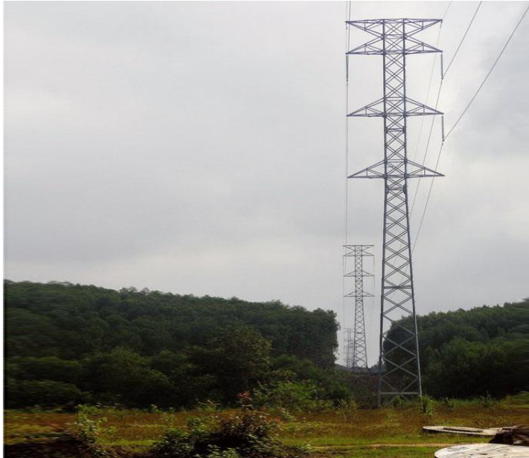
Đường dây 220kV An Khê - Quy Nhơn mạch 2, kết hợp cải tạo mạch 1
