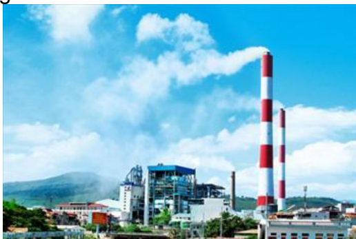
Chuyển đổi dầu FO – DO Nhà máy Nhiệt điện Uông Bí
