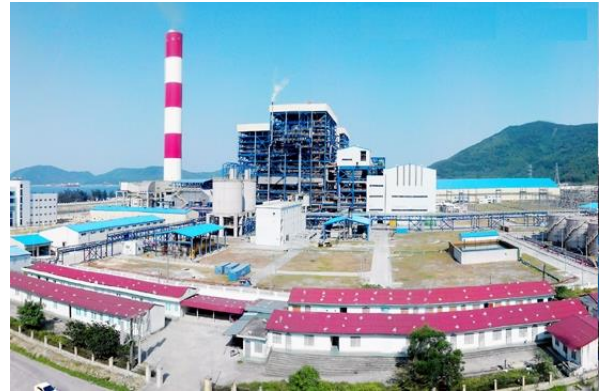
Lập định mức bảo dưỡng sửa chữa Nhiệt điện Vũng Áng 1
