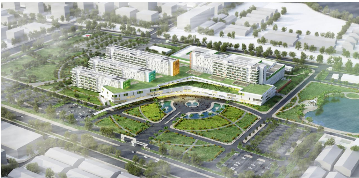
Dự án: Cơ sở 2 Bệnh viện Việt Đức
