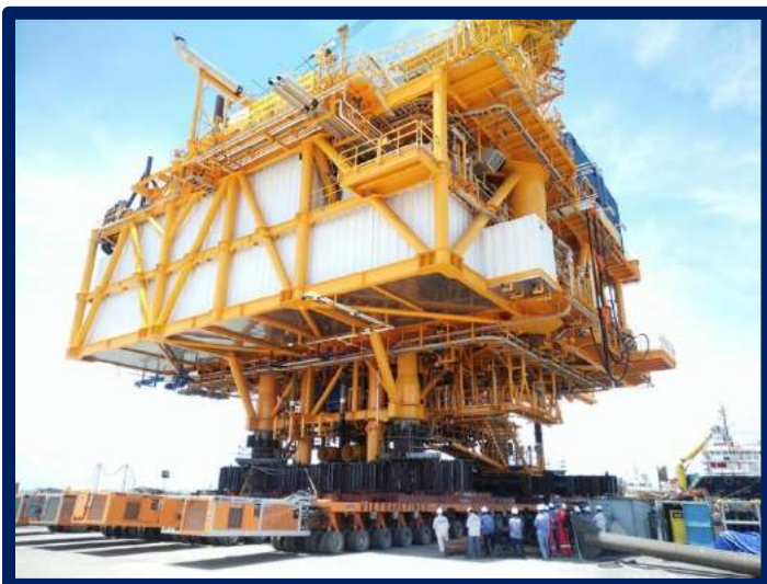
Vận chuyển và hạ thủy thành công kiện Topside ST-LQ nặng ~2.600 tấn từ vị trí chế tạo xưởng sà lan tại Cảng PVC-MS, Vũng Tàu.
