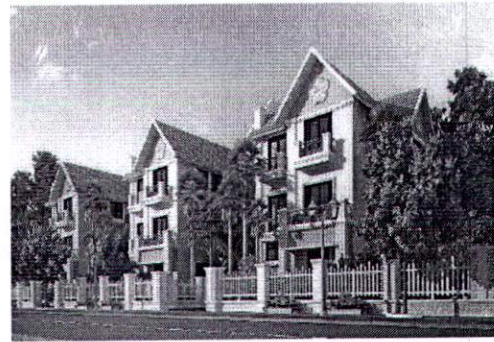
Hình ảnh 10: Sản phẩm nhôm Đông Anh lắp đặt tại Vincom Village
