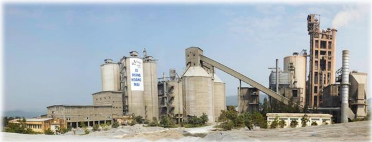
HỆ THỐNG NHÀ MÁY SẢN XUẤT XI MĂNG VICEM HOÀNG MAI
