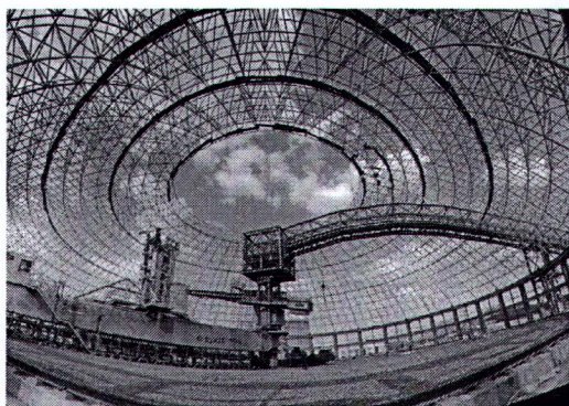
Hình ảnh 7: Giàn không gian CKĐA xuất khẩu sang Namibia-Châu Phi
