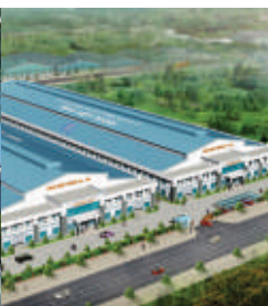
Nhà máy nhuộm Yên Mỹ Vinatex (Hưng Yên)
