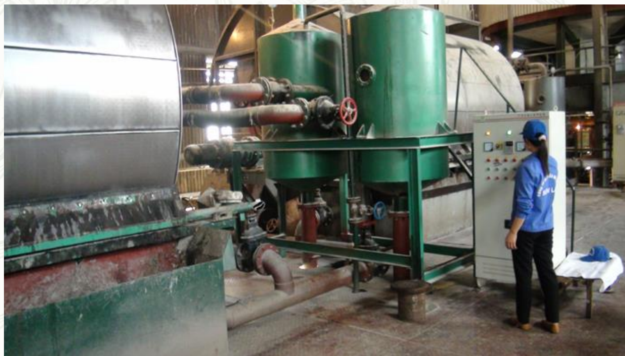
Hệ thống máy móc được đầu tư mua mới tại CTCP Mía Đường Sơn La
