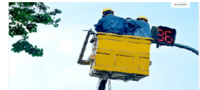
Thi công, duy tu sửa chữa hệ thống điện, chiếu sáng
