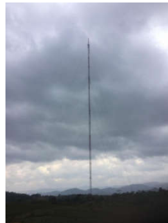
Trụ đo gió dự án NMĐG Tân Lập, tỉnh Quảng Trị
