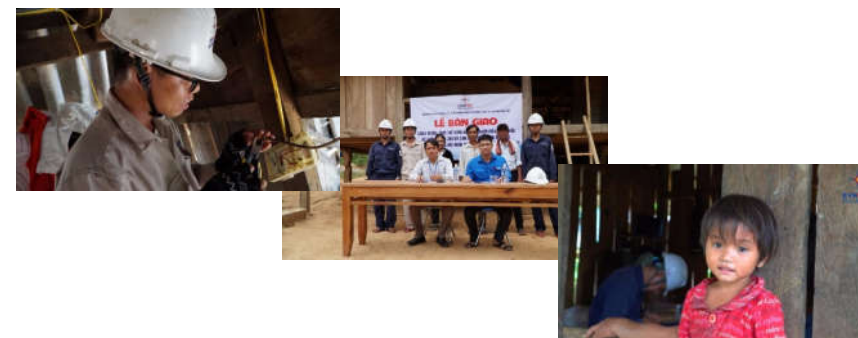
Thay thế bóng đèn tiết kiệm điện, sửa chữa hệ thống điện cho bà con đồng bào khu tái định cư thôn Húc Nghi, xã Húc Nghi, huyện Đakrông tỉnh Quảng Trị
