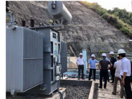
Đoàn Thanh tra Cục Kỹ thuật an toàn và Môi trường công nghiệp - Bộ Công Thương làm việc tại NMTĐ Đa Krông 1
