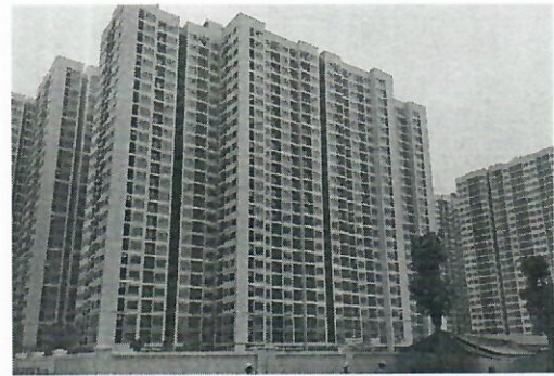
Hình ảnh 12: Sản phẩm DAA lắp đặt tại Vinhomes Ocean Park
