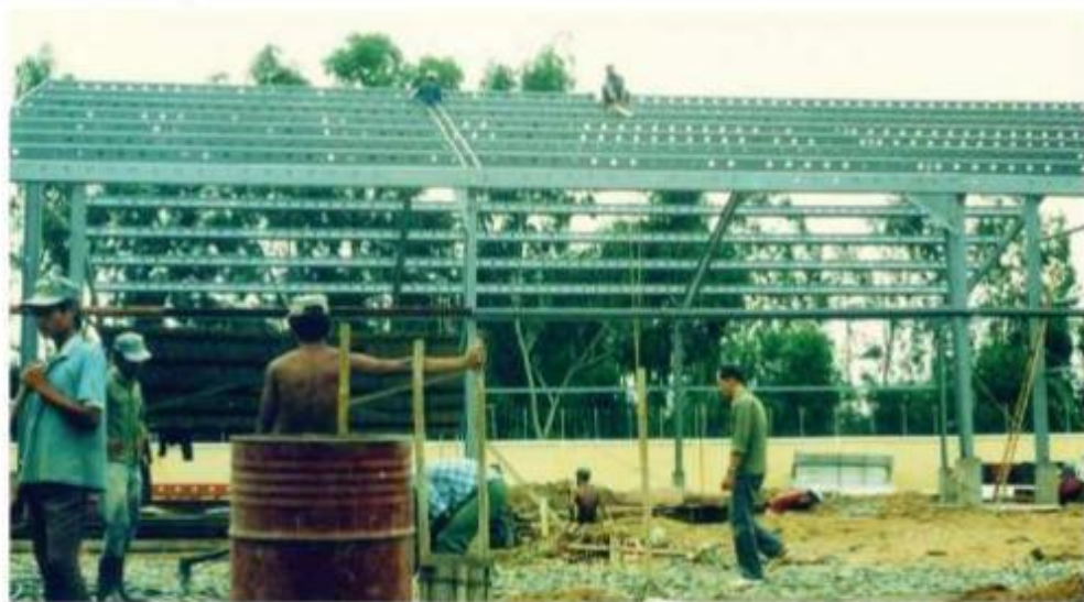
Khởi công xây dựng nhà máy
