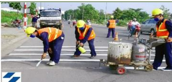
Duy tu đường, mương công thoát nước
