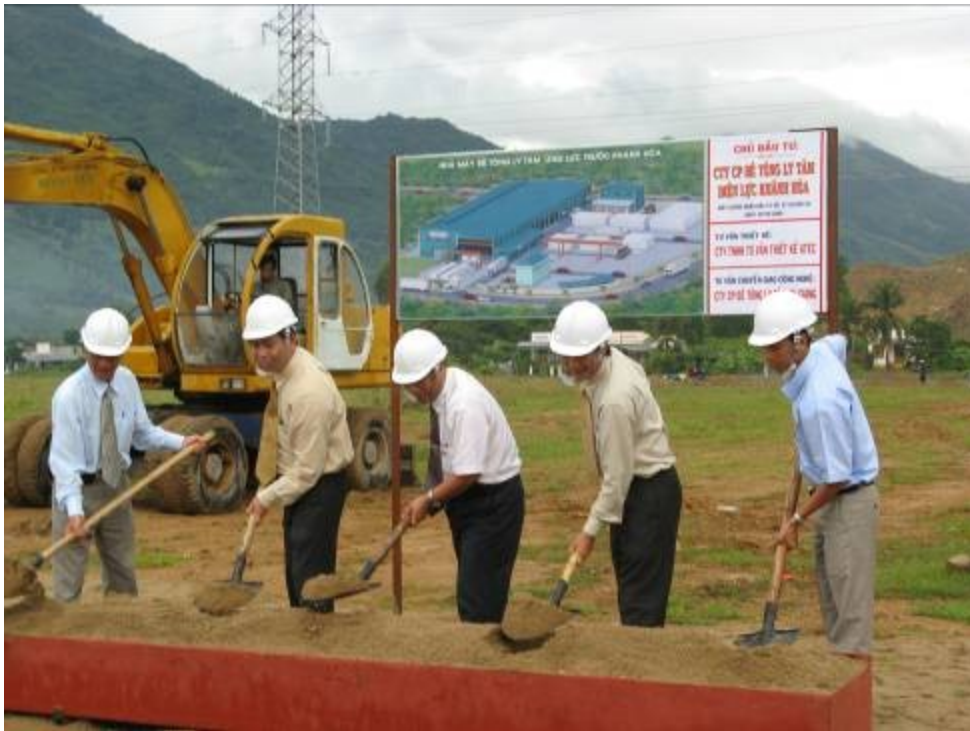
Lễ khởi công xây dựng Nhà máy Bê tông ly tâm dự ứng lực trước
