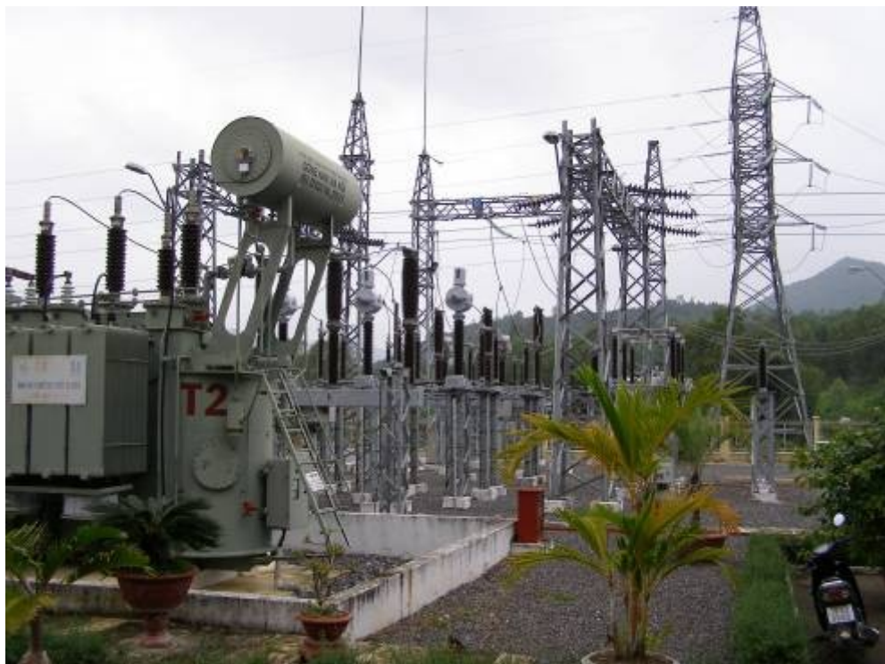
Trạm biến áp 110kV
