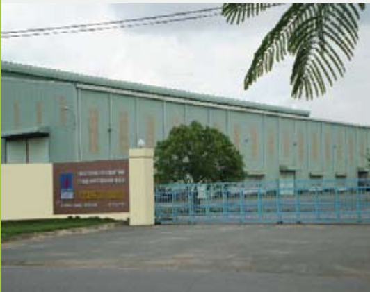
Hệ thống nhà kho, văn phòng làm việc của PST có diện tích 33.042 m 2 tại Khu Công nghiệp Hồ Nai – Thành Phố Biên Hòa, Tỉnh Đồng Nai
