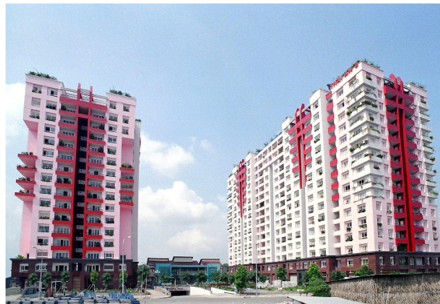
Dự án khu chung cư Thái An 3&4, Tp Hồ Chí Minh
