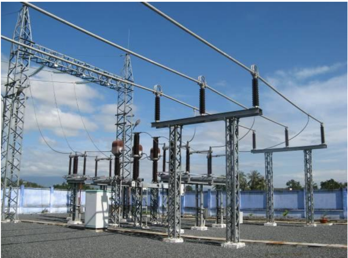
Trạm biến áp 110kV Bình Tân
