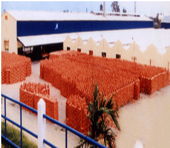
Nhà máy gạch Tuynel
