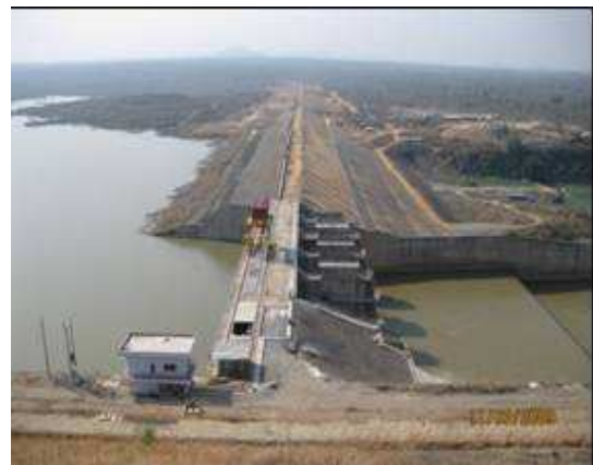
Thủy điện Buon Kuốp
