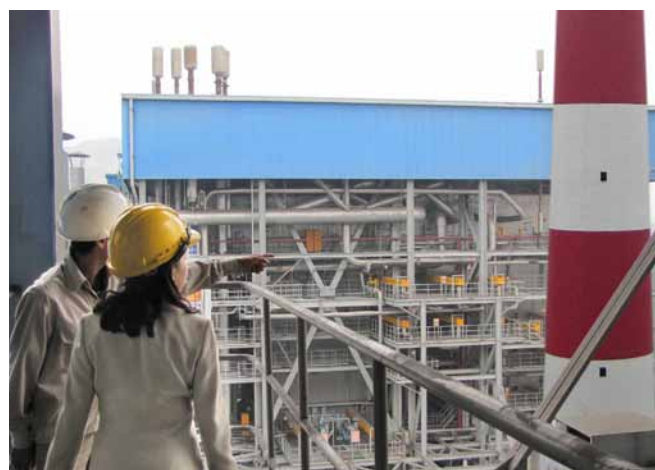
Nhà máy nhiệt điện Quảng Ninh
