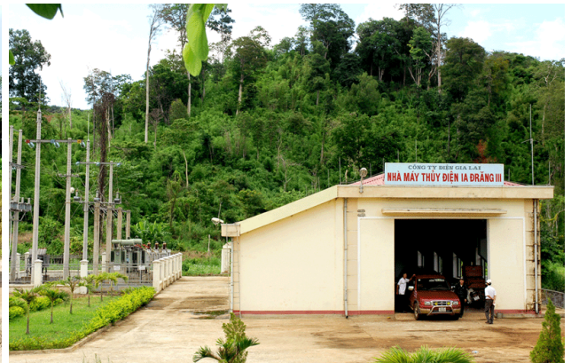
Ảnh: Nhà máy IaĐrăng3 (1,6MW) hoạt động năm 2005
