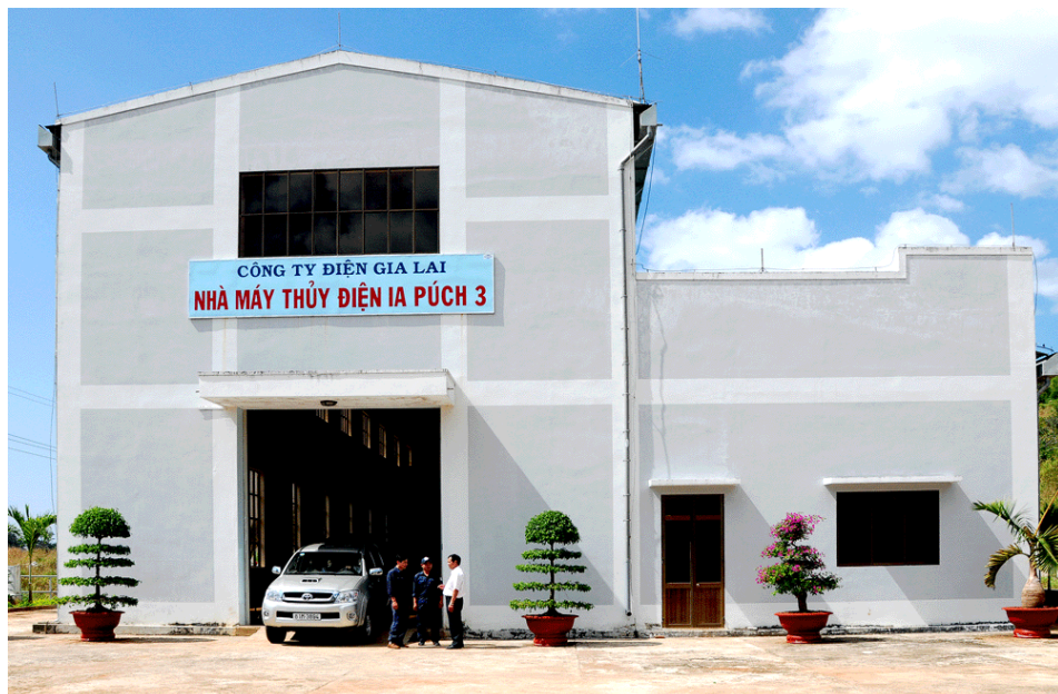
Ảnh: Nhà máy IaPuch3 – 6,6 MW, đưa vào hoạt động KD năm 2008
