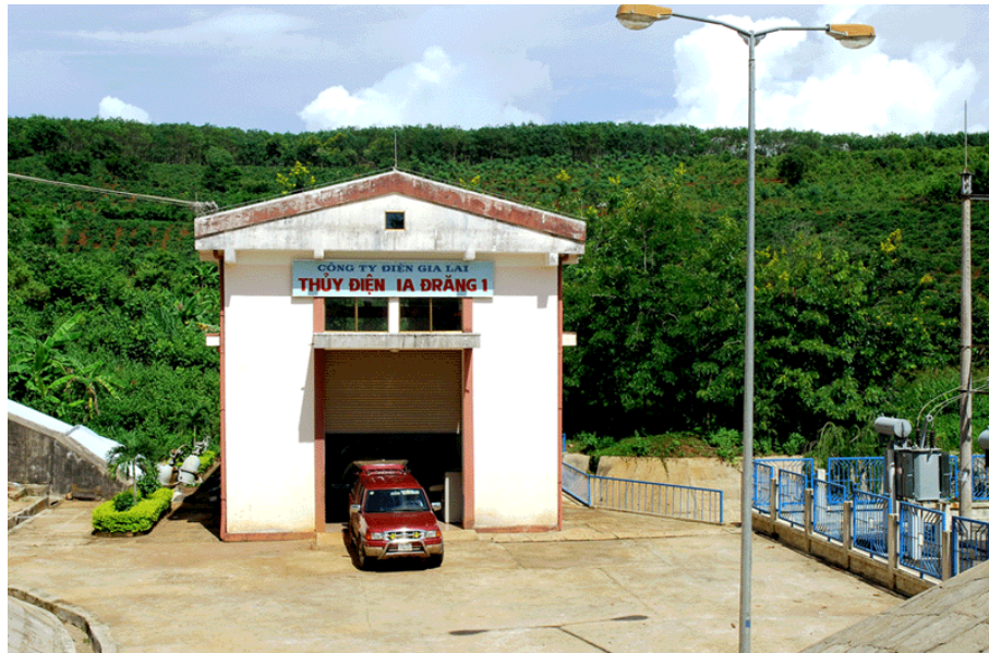
Ảnh: Nhà máy IaĐrăng1- 600 KW, Sự khởi nghiệp của TIC
