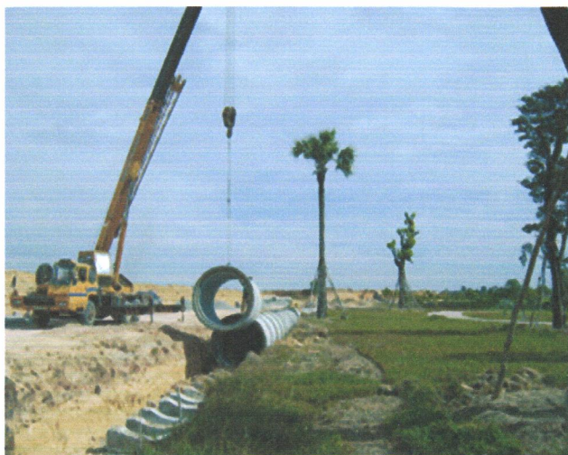
Thi công lắp đặt hệ thống cống thoát nước – KCN Mỹ Phước 3
