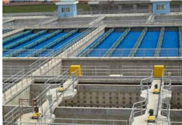
Nhà máy nước B.O.O Thủ Đức
