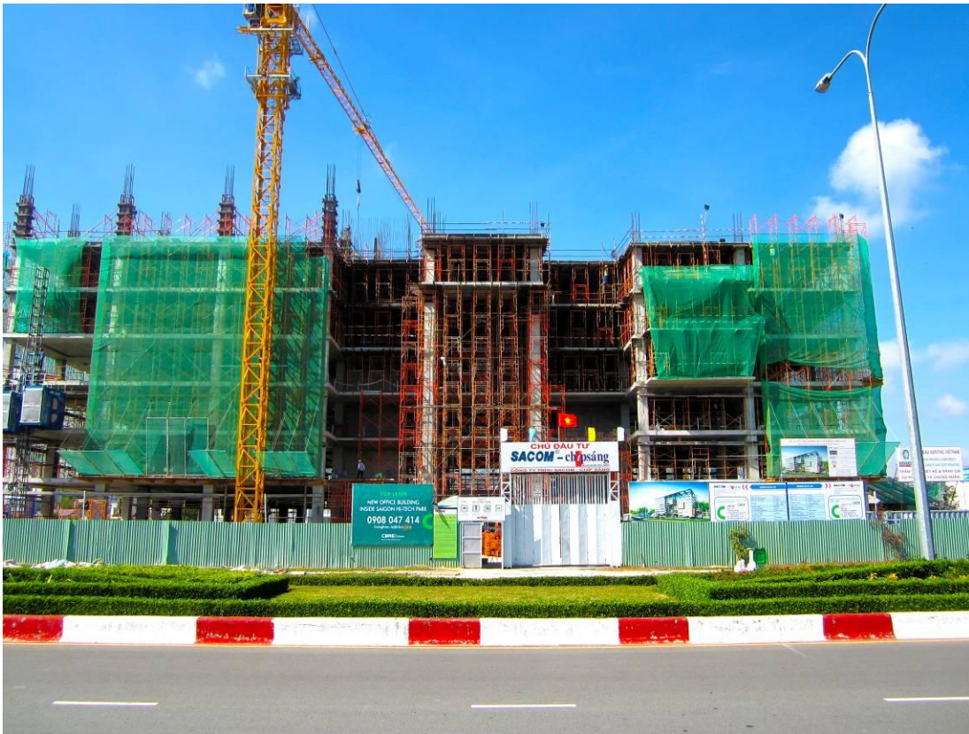
Hình thực tế : Tòa nhà không gian Internet Chip Sáng BCIS đang xây dựng tháng 3/2012
