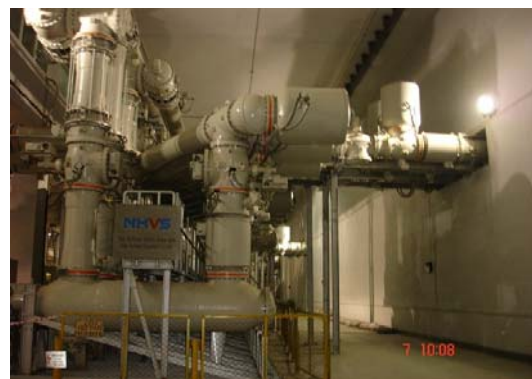
Trạm GIS-2400MW thủy điện Sơn La
