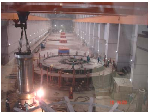
Công tác lắp đặt tổ máy 5 Thủy điện Sơn La
