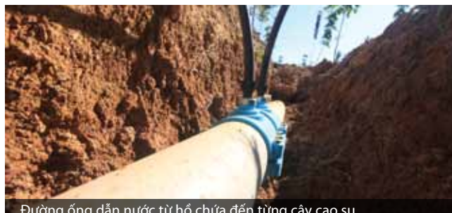
Đường ống dẫn nước từ hồ chứa đến từng cây cao su
