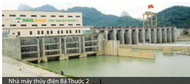
Nhà máy thủy điện Bá Thước 2
