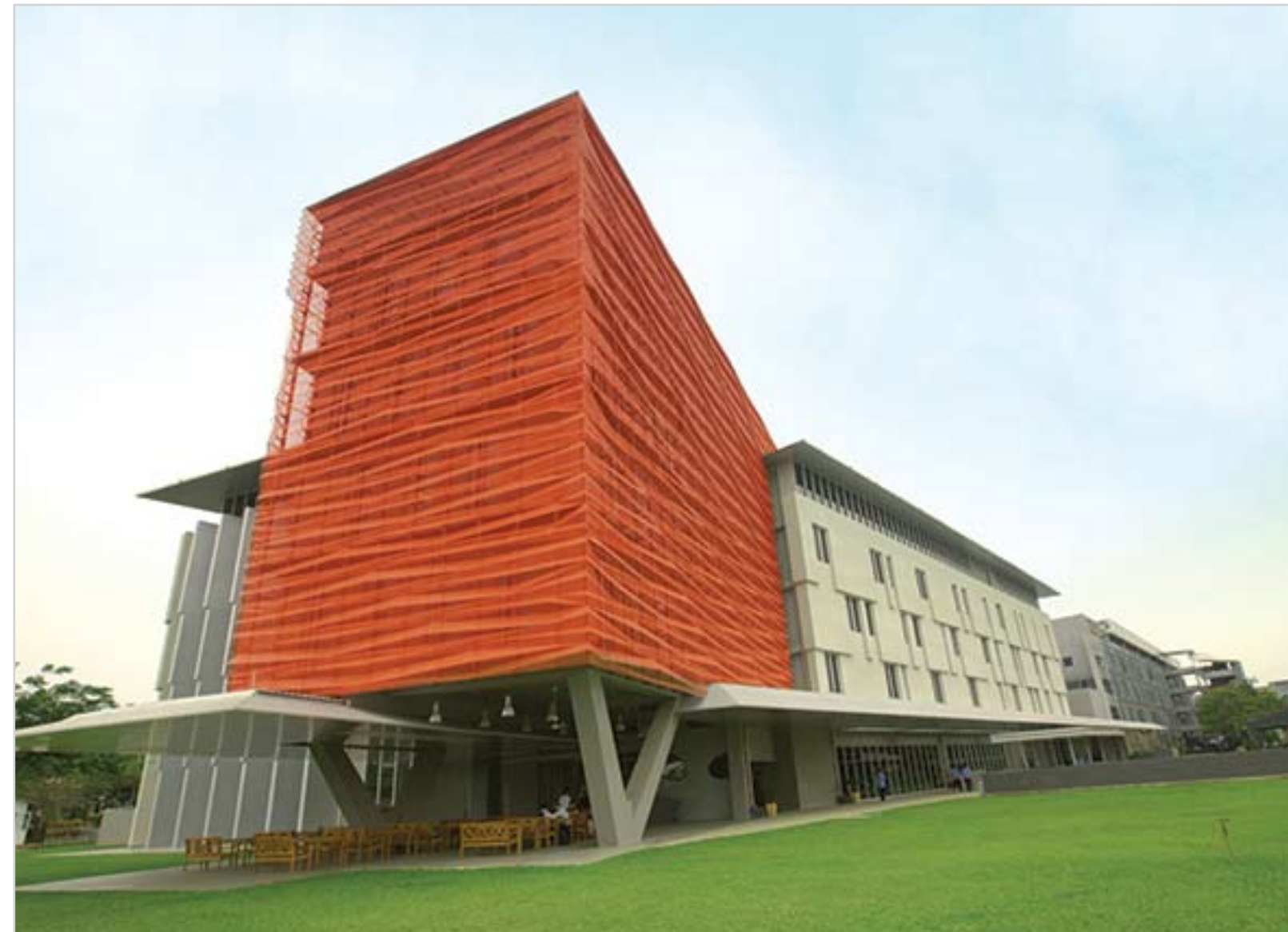
TÒA NHÀ GIẢNG ĐƯỜNG 2 - TRƯỜNG ĐẠI HỌC QUỐC TẾ RMIT TP.HCM Thầu chính kết cấu, hoàn thiện
