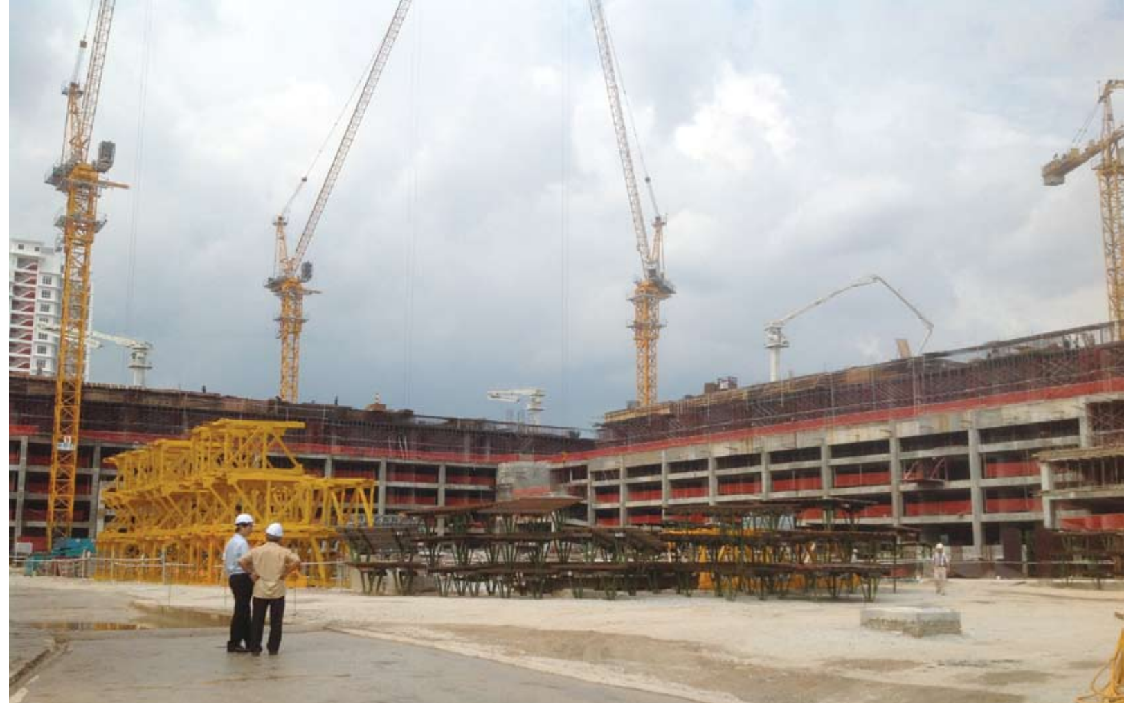
Công trình Le Yuan - Sri Petaling tại Kuala Lumpur do Hòa Bình quản lý xây dựng
