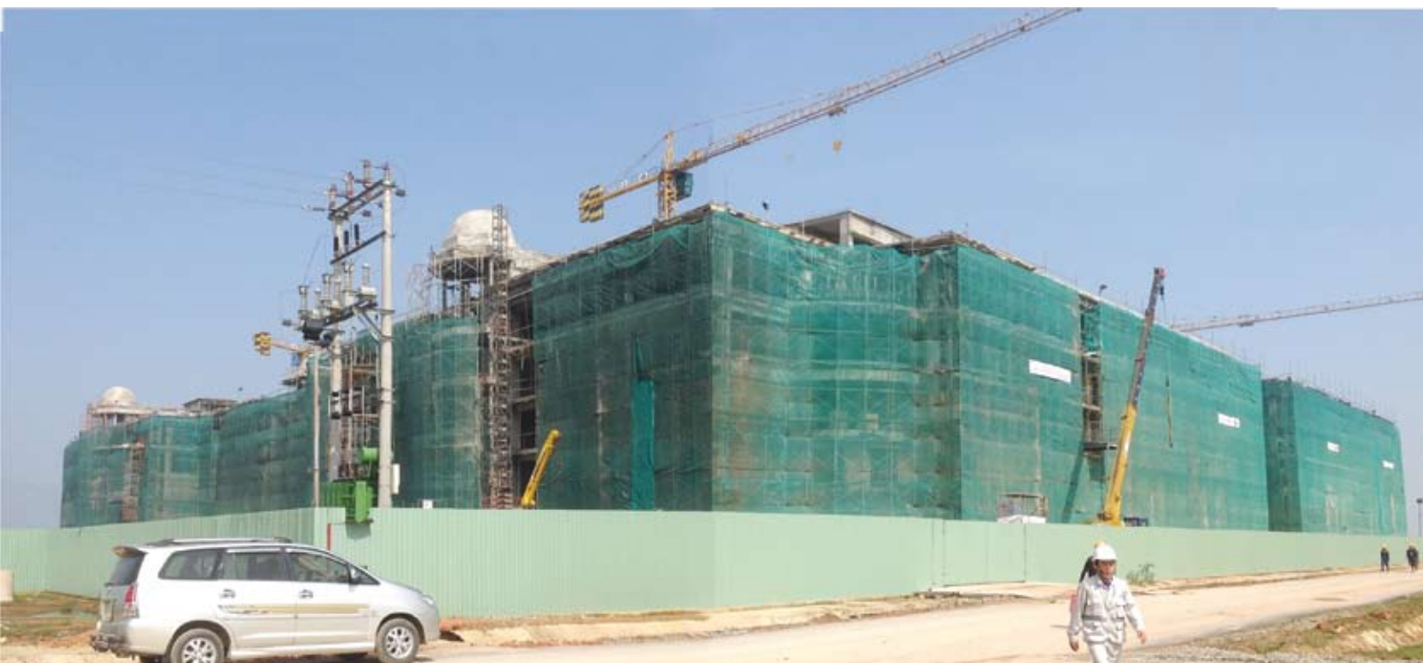
Một góc công trình khu nhà ở CBCNV của Khu công nghiệp Gang thép Formosa Hà Tĩnh
