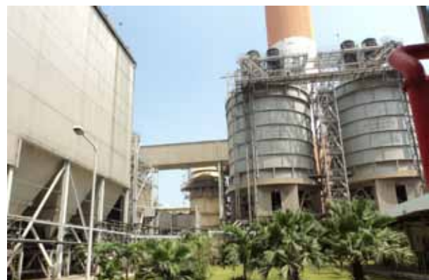
Nhà máy Nhiệt điện Phả Lại
