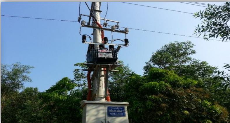
Trạm biến áp 30 kVA và đường dây được xây dựng tại thôn Pà Dấu
