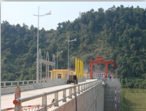
Thủy điện Sông Bung 5 – tháng 4/2013
