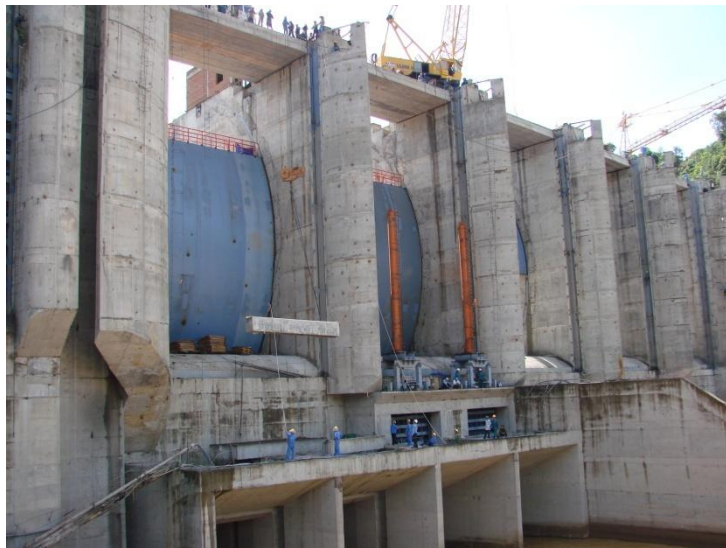
Thủy điện Sông Bung 5 – Đóng cổng dẫn dòng (8/12/2012)
