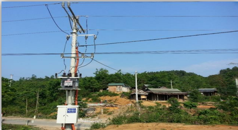
Trạm biến áp 50 kVA và đường dây được xây dựng tại thôn Pà Dấu
