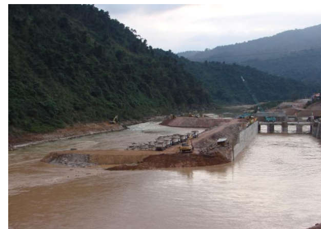
Thủy điện Sông Bung 5 – Ngăn dòng đợt 1 (2/2011)
