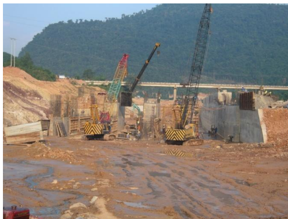
Thủy điện Sông Bung 5 – Thi công công trình dẫn dòng (10/2010)
