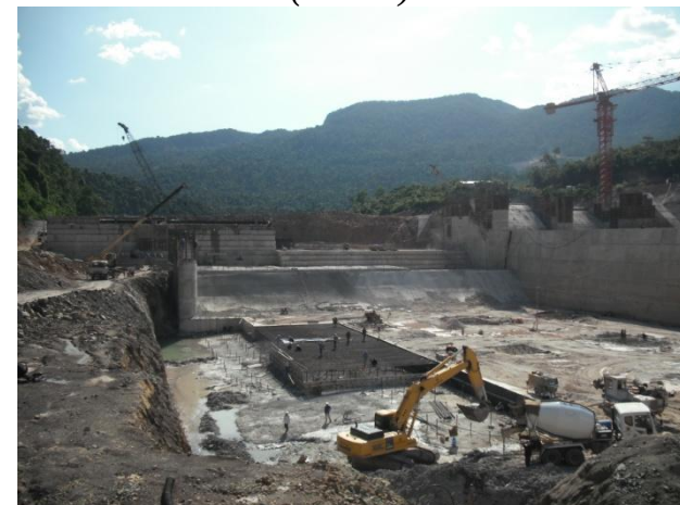
Thủy điện Sông Bung 5 – Thi công công trình bể tiêu năng (6/2011)
