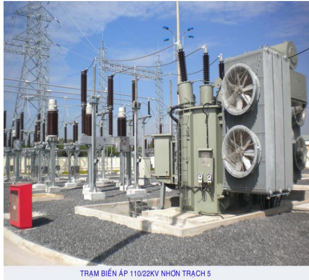
TRẠM BIẾN ÁP 110/22KV NHƠN TRẠCH 5
