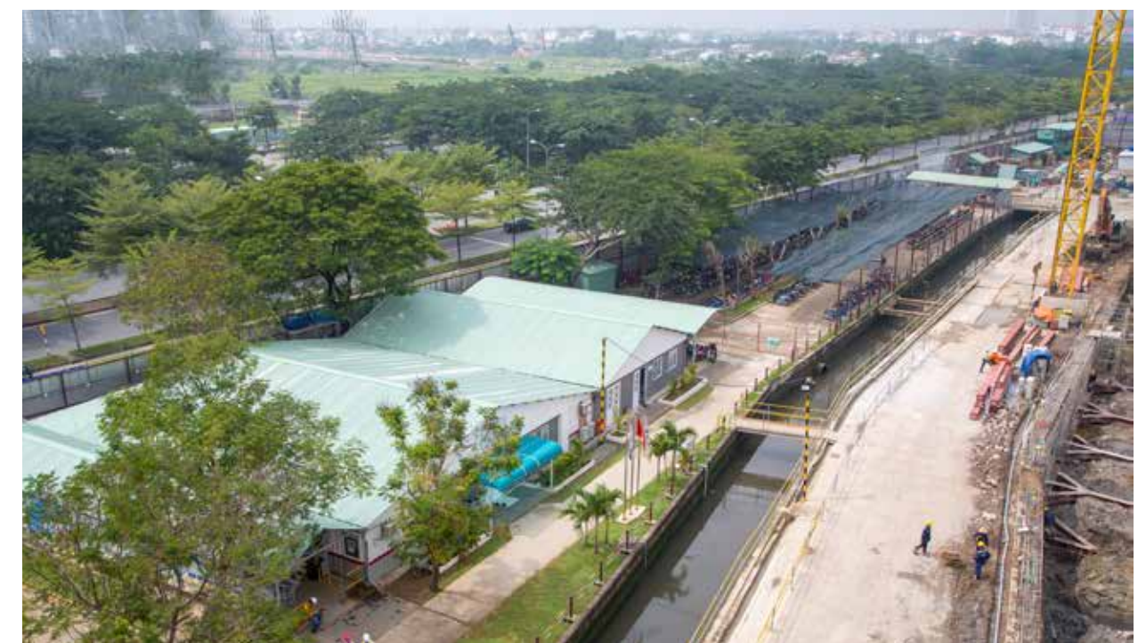
Khu vực thi công được vệ sinh sạch đẹp
