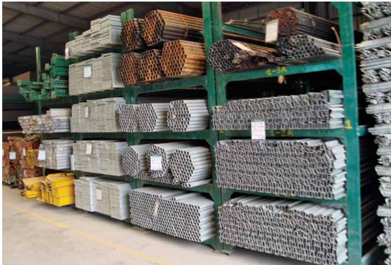
Vật tư thiết bị thi công được bảo quản tại kho
