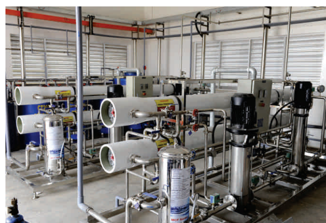
Hệ thống nước RO
