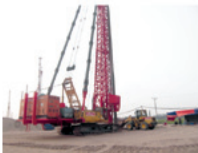
Thi công cọc cát đầm
