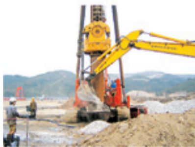
Thi công cọc đá
