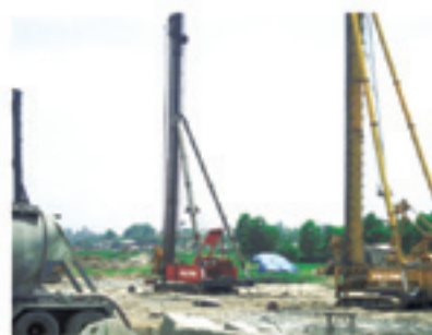
Thi công cọc xi măng đất
