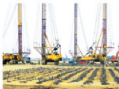
Thi công bắc thấm
