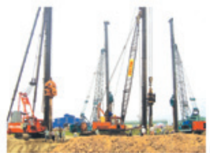
Thi công cọc cát
