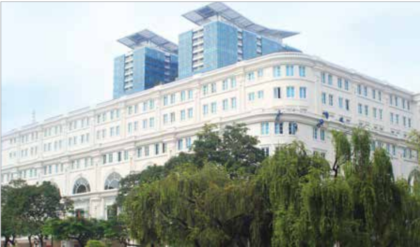
CÔNG TRÌNH VINCOM CENTER A
